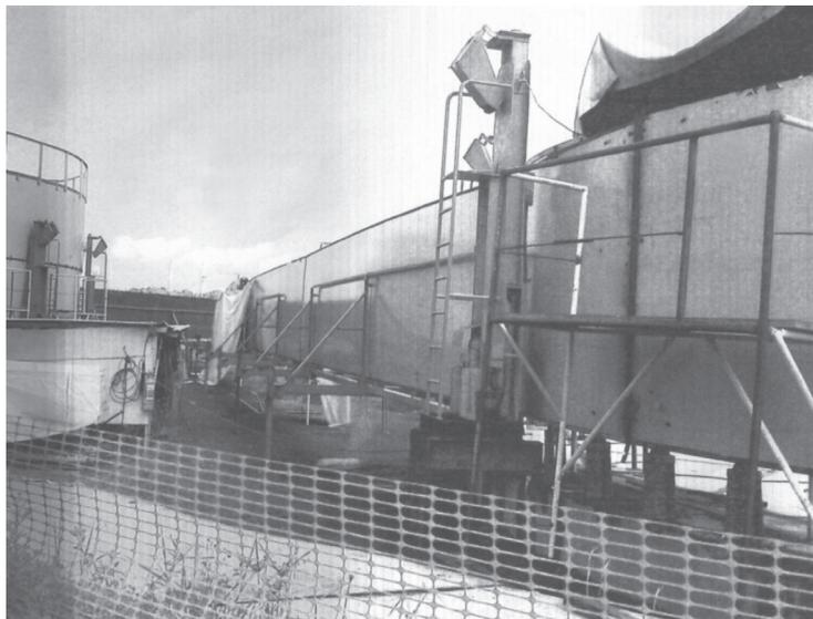
Figura 11.6 – Montagem com chapas não calandradas
