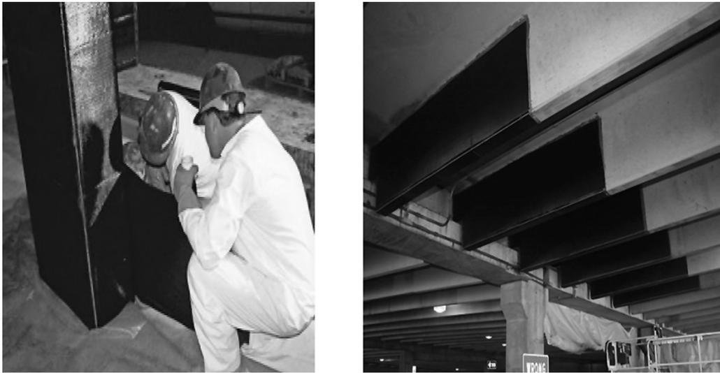
**Figura 25 – Exemplo de reforço de estruturas de concreto com compósitos poliméricos com fibras de carbono**
